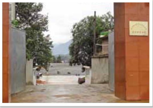
松溪縣鄭墩鎮“港閩希望小學”大門。
